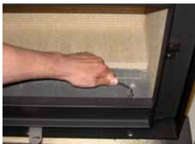
Placez le conduit de fumée avec le collier de serrage monté dans l'orifice circulaire du caisson de l'insert.
